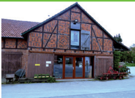
Die umgebaute Scheune am Lernort Kampfelder Hof im niedersächsischen Hiddestorf.
