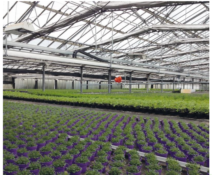
Abb. 3: Druckluftunabhängiges Verfahren/Axialventilatoren
