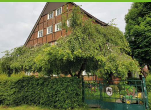
Neuer Glanz fürs alte Gemäuer. Um das Herzstück des Hellweghofs zu erhalten, musste es aufwändig saniert werden.
